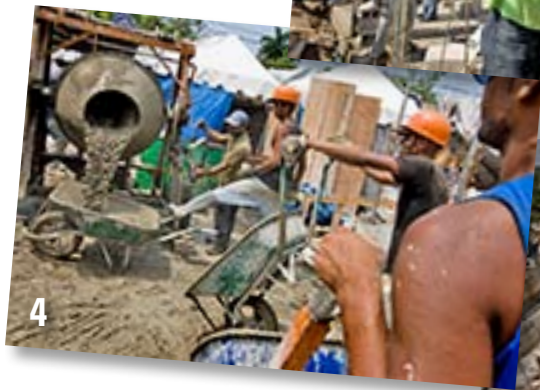
4-5 Het beton wordt gestort. Zo krijgt de nieuwe school een goede basis.
